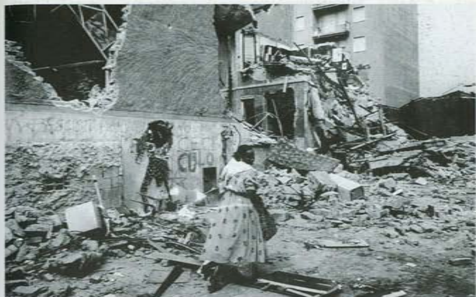
Le ruspe del Comune iniziano un lavoro di demolizione sistematica - e non autorizzata - delle strutture e dei locali del centro. Gli arrestati resteranno in carcere fino al giorno successivo, ma già a poche ore dallo sgombero, da tutta Italia cominciano ad affluire centinaia di persone e di attestati di solidarietà. Contemporaneamente esplode la polemica sull'illegalità dell'intera operazione, e la stessa sera le "macerie" vengono rioccupate.
